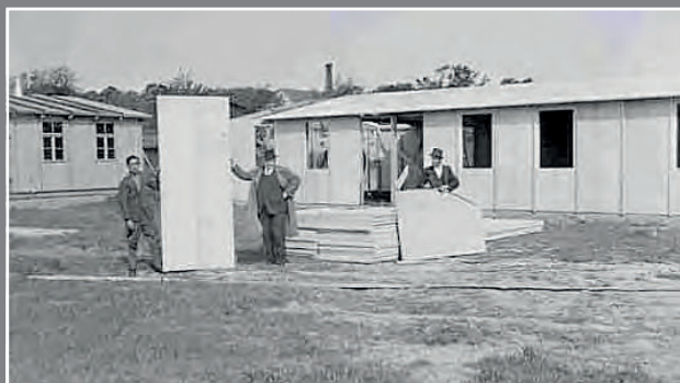
Aufbau von Baracken am Küsterteich durch die Firma Siegfried.
